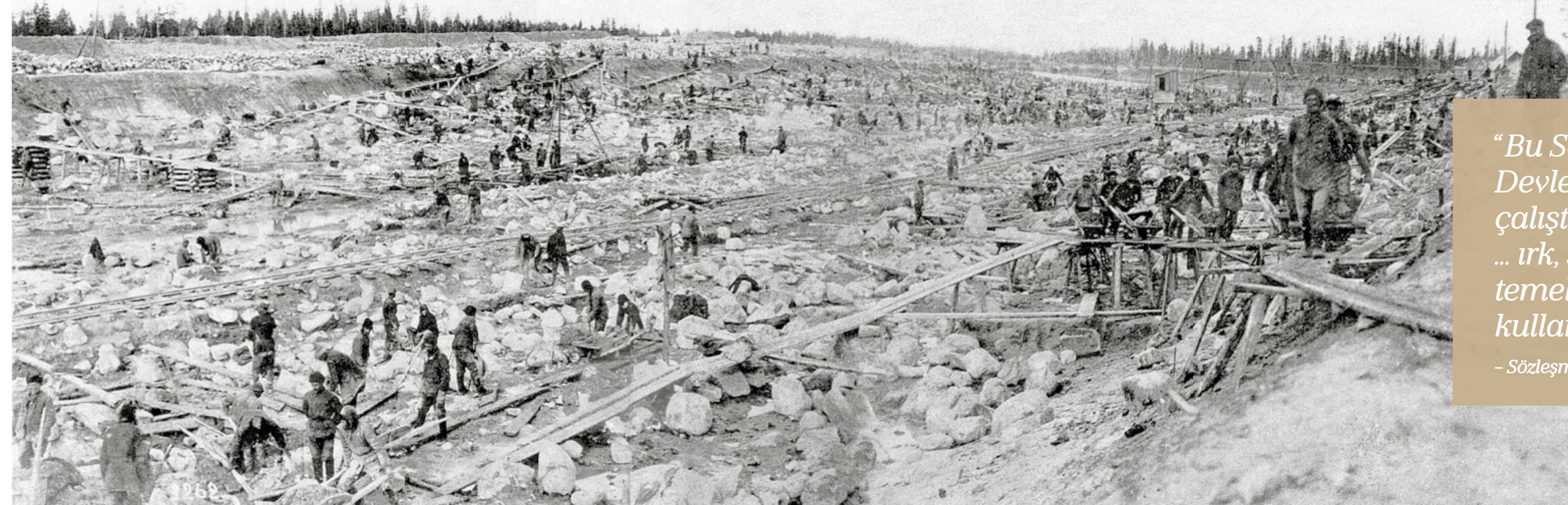
Beyazdeniz-Baltık Kanalı inşaatı (1932)
